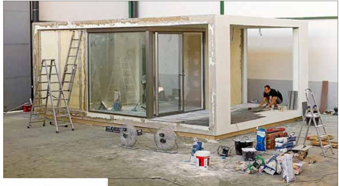
Proceso de construcción de un módulo prefabricado con Compopak (arriba) y resultado final una vez concluido (abajo). / EL MUNDO
